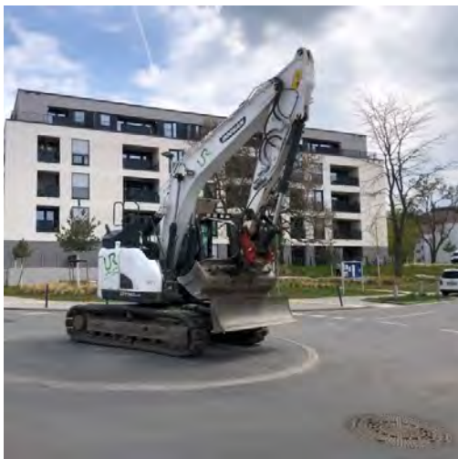
Abbildung 31: Baustellensituation in der Lincoln-Siedlung (Quelle: Wissenschaftsstadt Darmstadt 2021)
