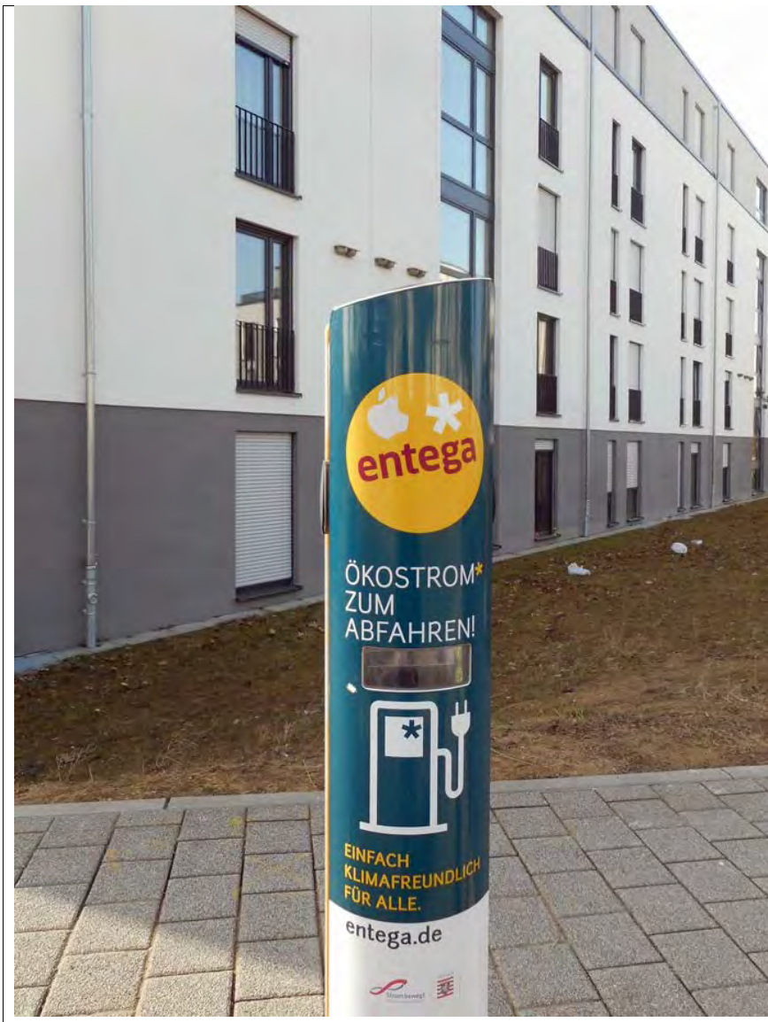
Abbildung 14: E-Ladesäule der Entega (Quelle: StetePlanung)
