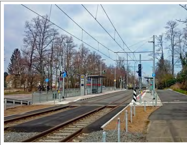
Abbildung 9: Neue Straßenbahnhaltestelle (Quelle: StetePlanung)
