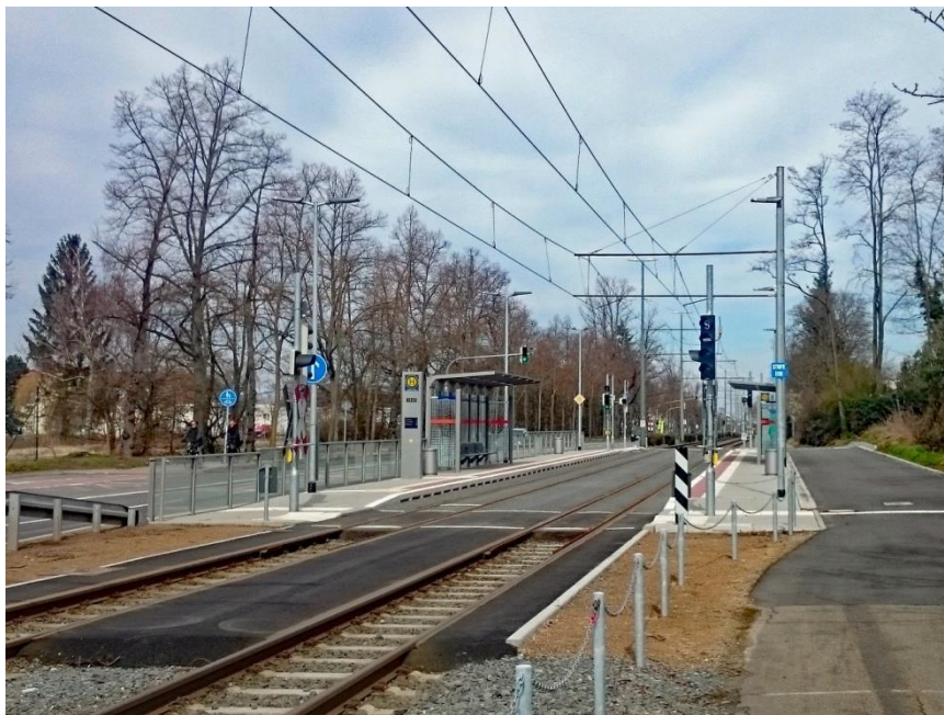
Abbildung 9: Neue Straßenbahnhaltestelle (Quelle: StetePlanung)
