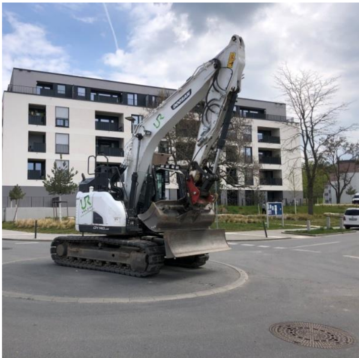
Abbildung 31: Baustellensituation in der Lincoln-Siedlung (Quelle: Wissenschaftsstadt Darmstadt 2021)
