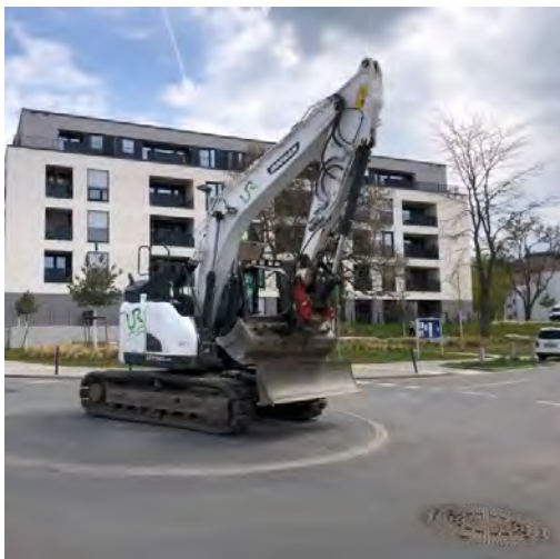
Abbildung 31: Baustellensituation in der Lincoln-Siedlung (Quelle: Wissenschaftsstadt Darmstadt 2021)
