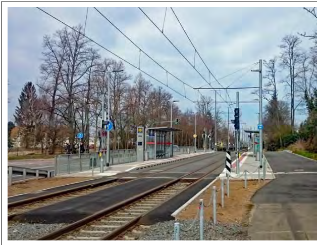
Abbildung 9: Neue Straßenbahnhaltestelle (Quelle: StetePlanung)
